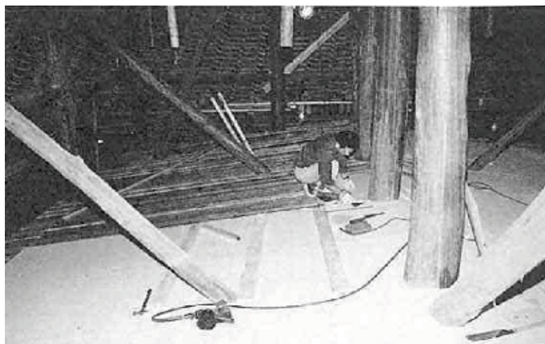
写真 15 小屋組内の石膏ボード（E寺）
