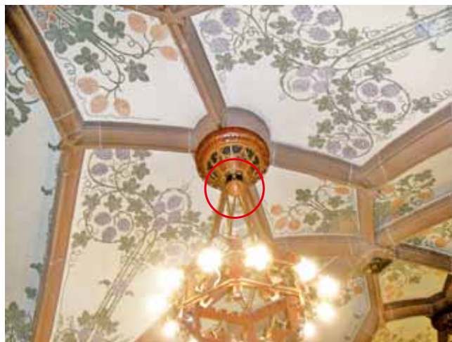
写真 11 シャンデリアの中に設置された感知器（ドイツ）
