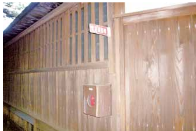
写真8 自動火災報知設備の発信機（C施設）
